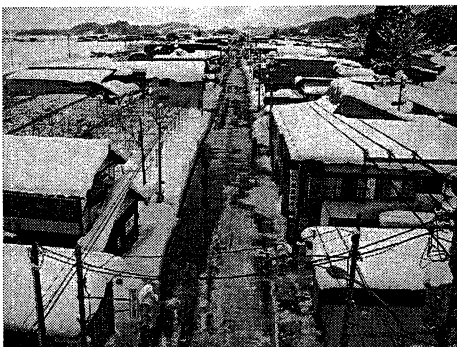
写真2 実施後の状況
