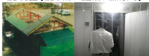
建屋上部を開放状況
