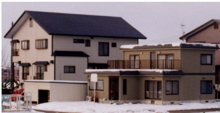
【自然落雪式屋根（左）と耐雪式屋根（右）】
