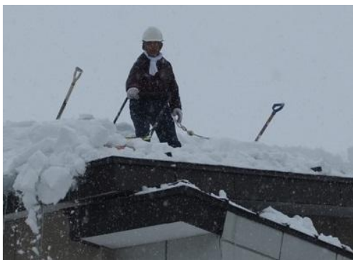
【屋根の雪下ろし作業】
