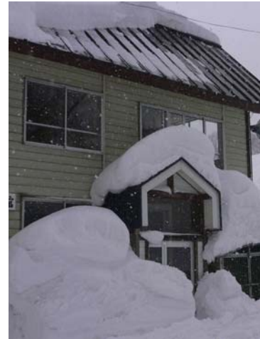
堆雪スペースに玄関を設けた悪い例
