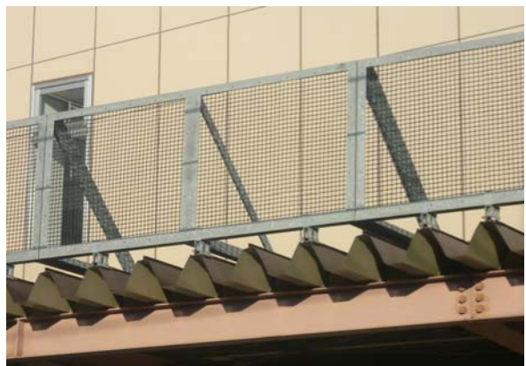
雪庇切りの設置例（網目の間隔は5 cm程度）
