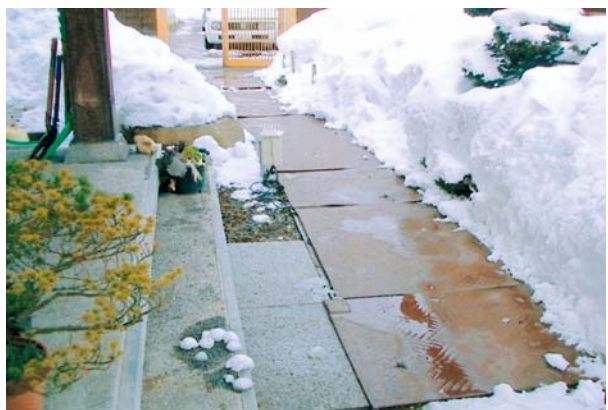
融雪ゴムマットを敷設した例
