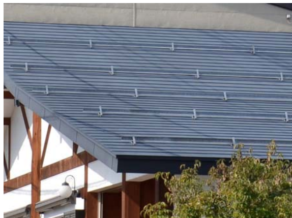
雪止め金具による落雪防止屋根
