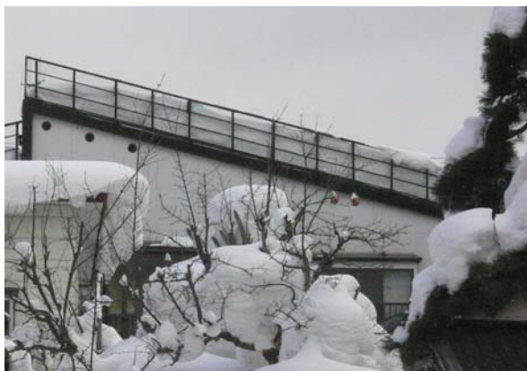
雪庇切りの設置例（網目の間隔は5 cm程度）
