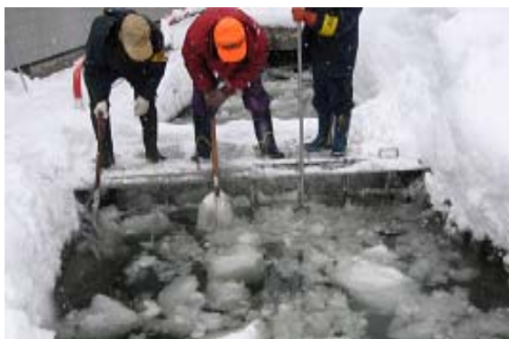
流雪溝の雪の塊の共同除去・管理作業
