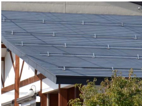
図Ⅱ-23 雪止め金具による落雪防止屋根
