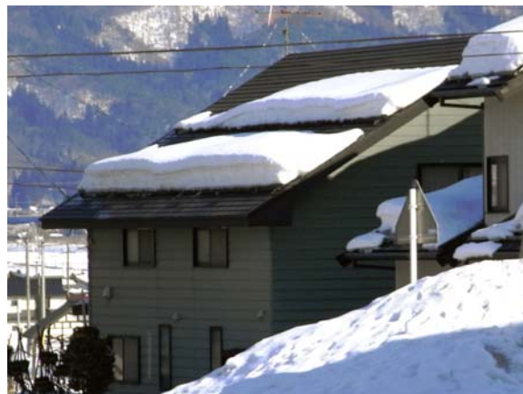
図Ⅱ-23 雪止め金具による落雪防止屋根
