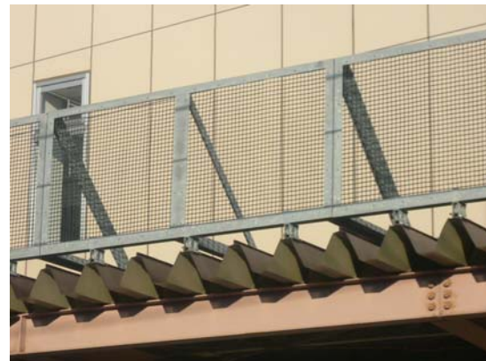
図Ⅱ-26 雪庇切りの設置例（網目の間隔は5 cm程度）
