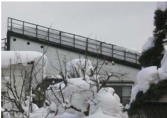
図Ⅱ-26 雪庇切りの設置例（網目の間隔は5 cm程度）
