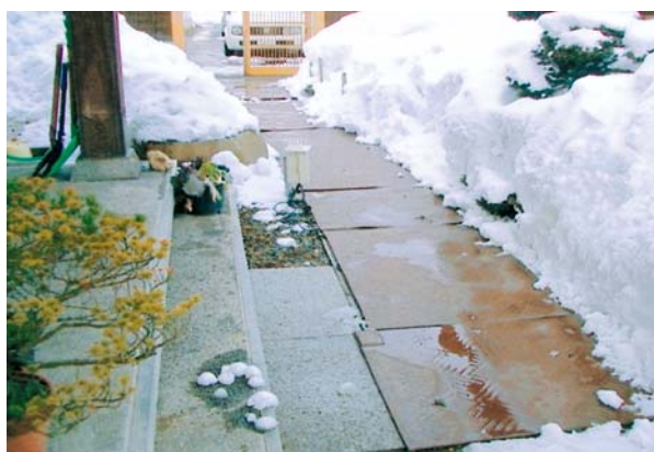
図Ⅲ-2 融雪ゴムマットを敷設した例
