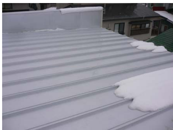
図Ⅱ-18 無散水方式（温水循環方式）
