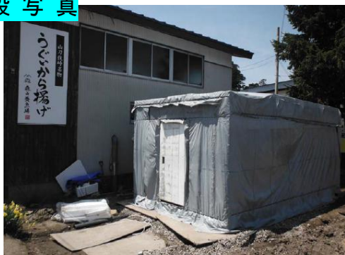
完成した雪むろの全景
