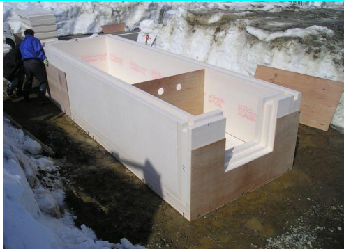
組立工事完了
