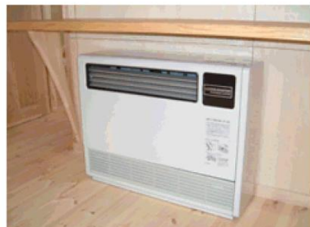
冷水を冷風に変える熱交換型暖房システム（ファンコイルユニット）
