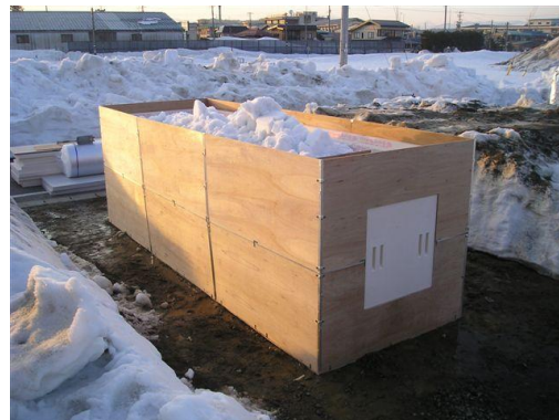
コンパネで覆い雪を入れた状況
