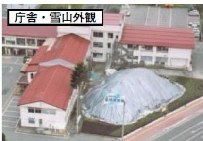
山形大学工学部の協力を得て構築された本システムは、雪山の融雪水による「水冷」と雪山本体からの「空冷」の2段階で冷熱を採取し除湿を行うとともに冷気を2重管の内側を通して庁舎内冷房を行い、外側を通して雪山に回収させ循環させることで安定的な冷房を可能としている。
