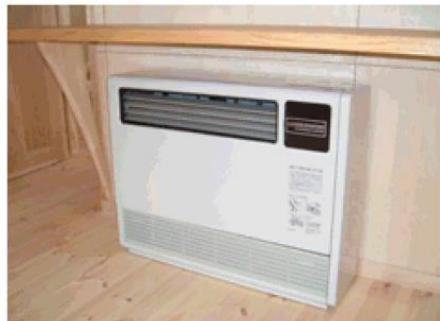
冷水を冷風に変える熱交換型暖房システム
