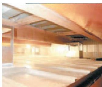
構造はボイラーで乾燥室内の温度を上昇させ、材木に含まれる水分を蒸発させるまでは従来と同じ。この後の工程で、二重構造とした屋根の間に水分を含んだ空気を雪が積もって冷えている屋根に当て、雪氷熱で結露させて除湿します。この二重屋根は夏の間は太陽熱に暖められた高温の空気を乾燥室内に入れることで、ボイラー燃料代の削減が図られます。また、ボイラーも廃材と油の両方が使用できるハイブリッド型を採用しています。
