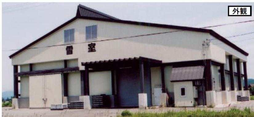
貯雪庫と貯雪庫の間で冷風を循環させ、2,600俵の米と50tのラ・フランス、そば50俵、啓翁桜を低温貯蔵している。
