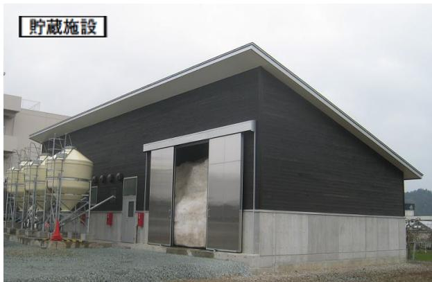
平成 26 年 4 月に新たに開校した「山形県立村山産業高等学校」の新産振校舎 1 階食品加工室に雪冷房システムを導入している。また、同校舎では、雪冷房システムのほか太陽光発電システムやペレットボイラーシステム等再生可能エネルギーを積極的に取り入れている。
