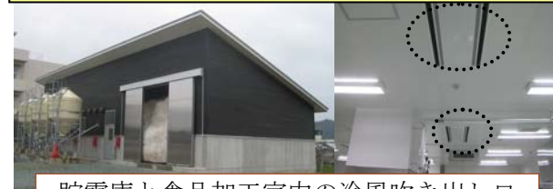
貯雪庫と食品加工室内の冷風吹き出し口
