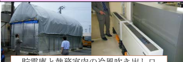
貯雪庫と執務室内の冷風吹き出し口
