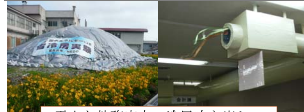
雪山と執務室内の冷風吹き出し口
