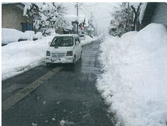
沿道の敷地からの排雪で狭くなった車道
