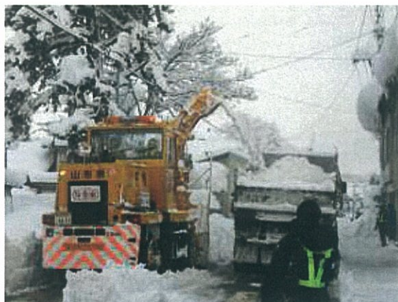
ダンプトラックへの積み込み作業
