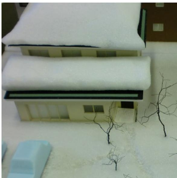
住宅（玄関）へのアプローチ方向に落雪しないように屋根勾配を取ることが重要であるが、やむを得ない場合には、融雪装置を設置するなどして対処しなくてはならない。
