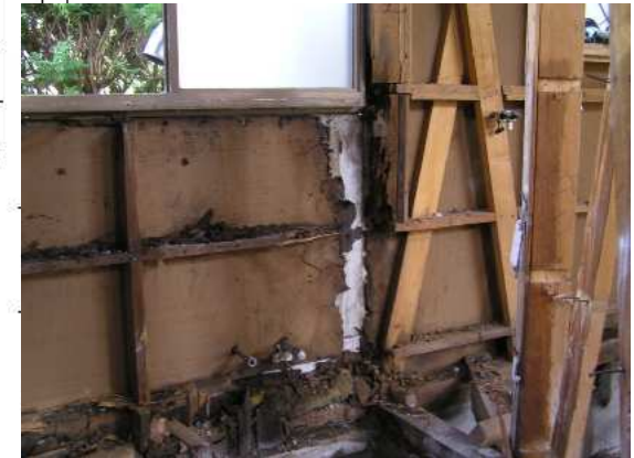
㊨：浴室の窓台から内部に水が入って腐食。
