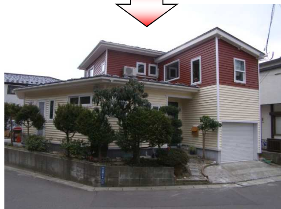
改修後； 外観 樹脂サイディング® (30年保証付き)
