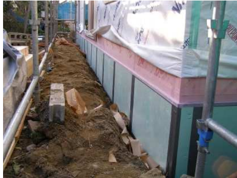
外廻り；基礎断熱。断熱材の小口やジョイントは防蟻テープで強化
