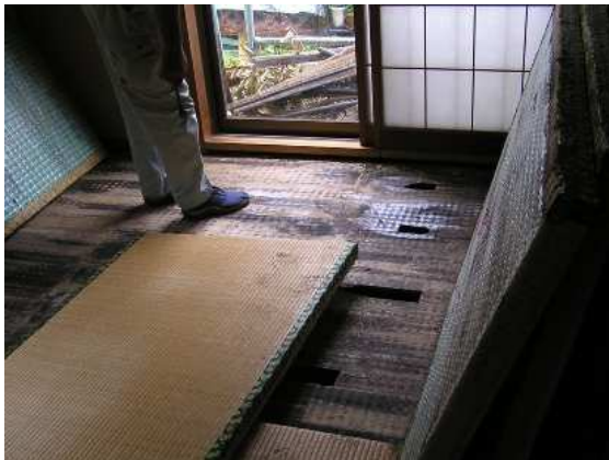
㊧：変にゾワゾワしたので和室の畳を外してみたら・・・ 湿気でカビがびっしり。
