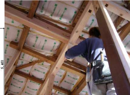
屋根；屋根断熱の下に充填断熱で2回目の断熱
