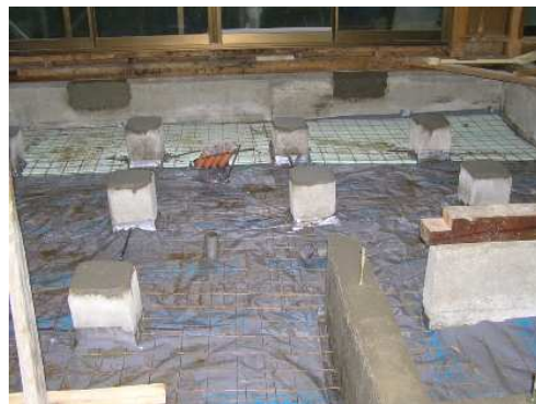
内部床下部分。基礎補強し防蟻防湿シートと断熱材を施工し土間コン打設
