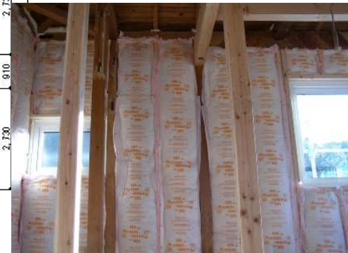
壁の断熱； 内部より充填断熱
