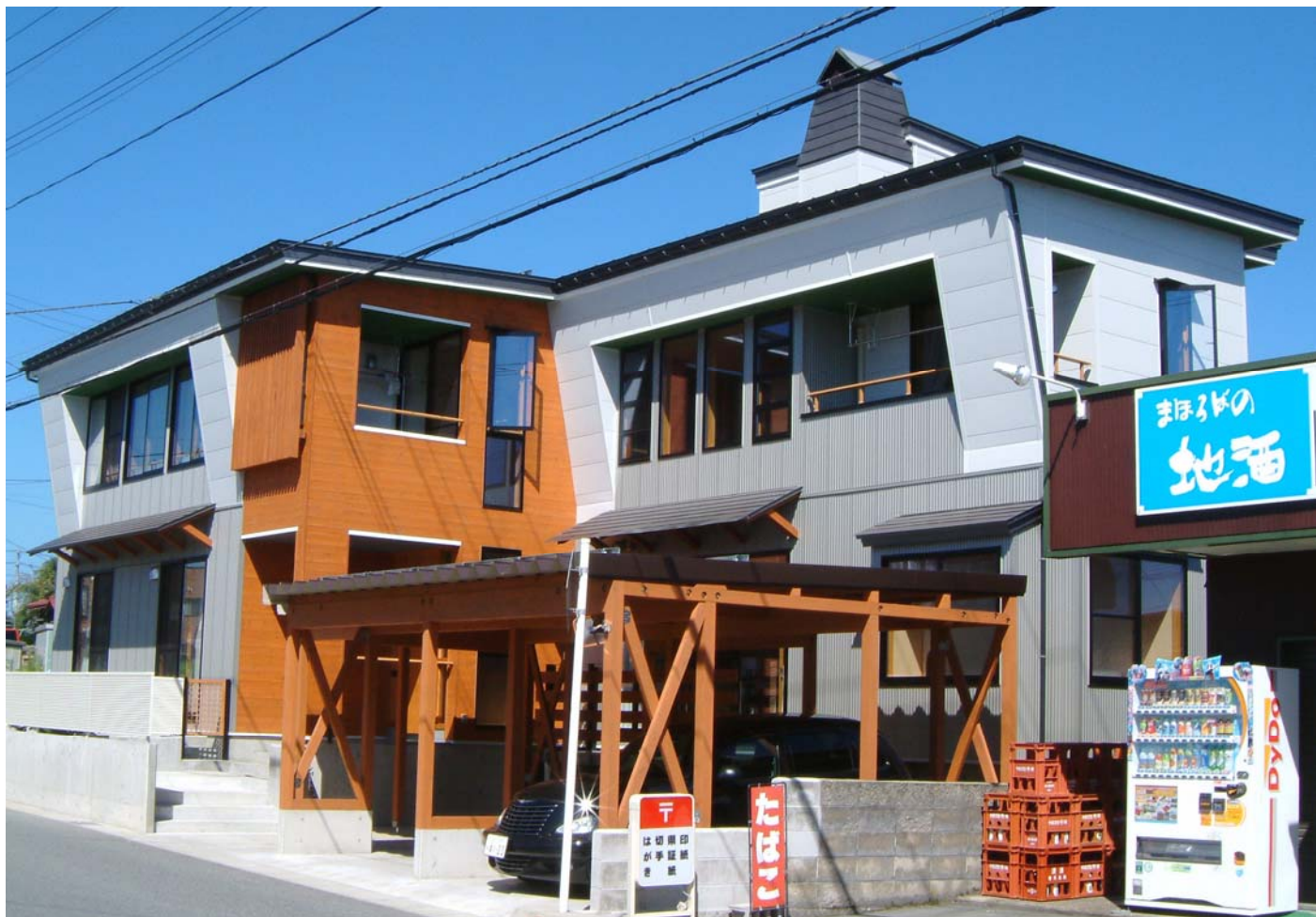
S宅（米沢市） 木造2階 積雪2m想定 耐雪型木造住宅 専用住宅 延床面積 193.77 m 2 長期優良住宅
